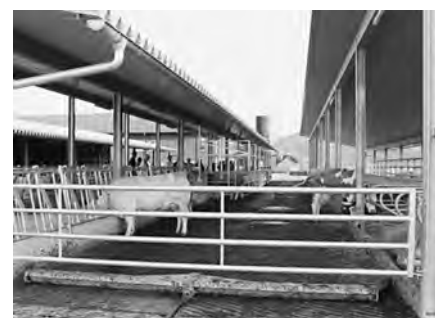
Fig. 5.10: Lorsque les axes d'évacuation sont droits, les racleurs fixes conviennent bien. Dans ce cas, il n'est pas nécessaire d'ouvrir, ni de fermer les portes et les séparations entre les différents groupes d'animaux.
