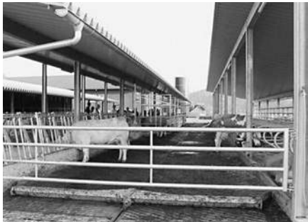
Fig. 5.10: Lorsque les axes d'évacuation sont droits, les racleurs fixes conviennent bien. Dans ce cas, il n'est pas nécessaire d'ouvrir, ni de fermer les portes et les séparations entre les différents groupes d'animaux.
