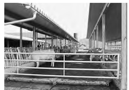
Abb. 5.10: Zur Entmistung gerader Mistachsen eignen sich stationäre Schieber. Zwischen einzelnen Tiergruppen entfällt das Öffnen und Schliessen von Toren und Abtrennungen. Foto: Agroscope ART
