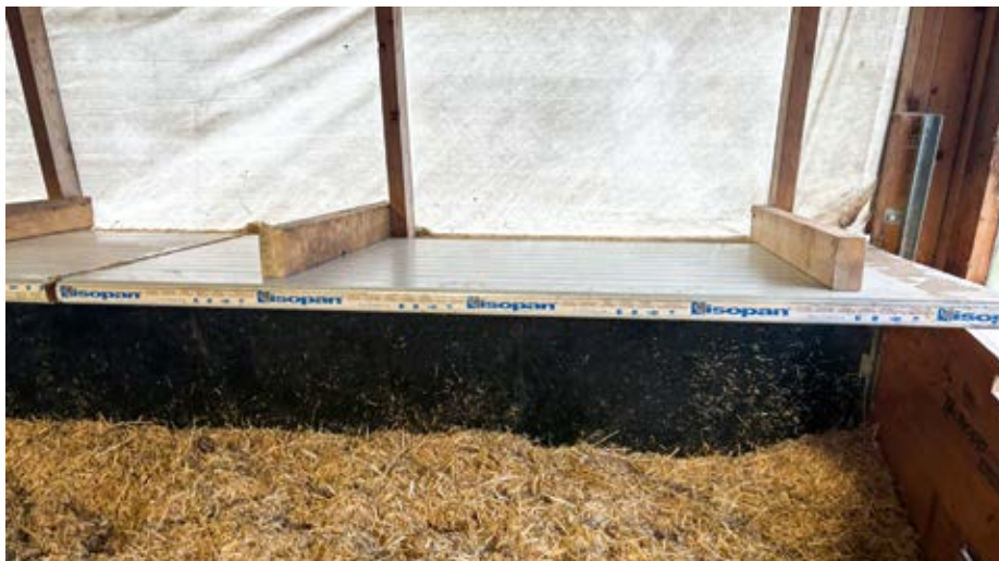
Mit verschiedenen Massnahmen, wie hier mit einem zusätzlichen «Dach», kann im Kälberschlupf ein optimales Klima geschaffen werden. (Foto: Helen Huber)
