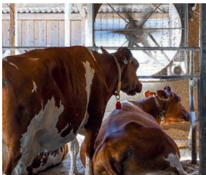
Ventilatoren sind eine gute Möglichkeit, das Klima und die Luftzirkulation in Ställen zu verbessern.
