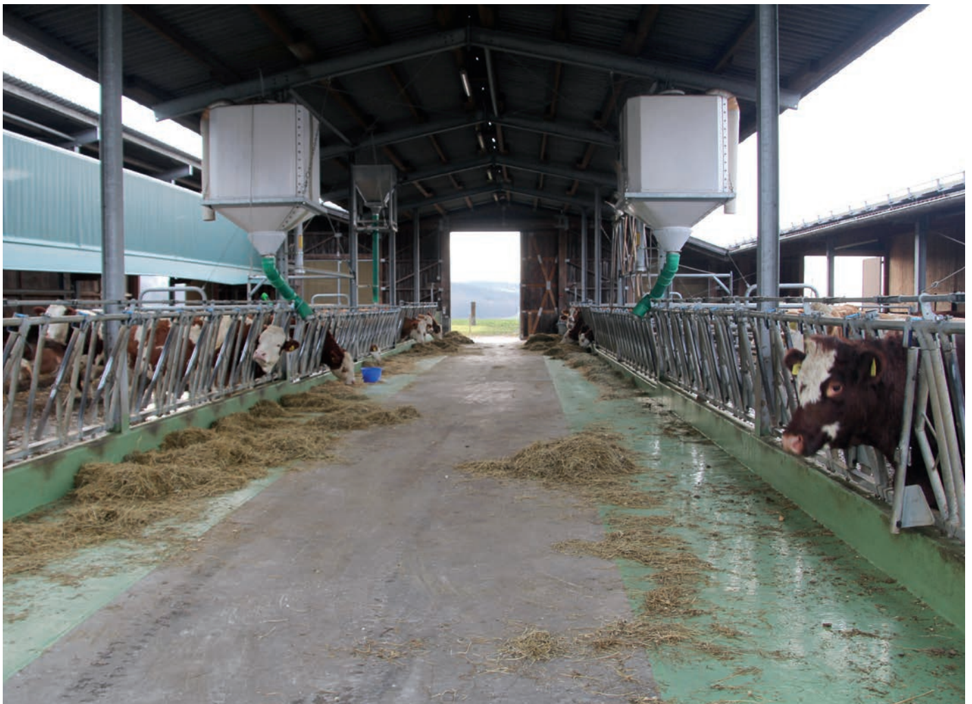
Aperçu de l'écurie et des possibilités de stockage (en partie construction propre) pour les concentrés (devant) et les minéraux (derrière).
