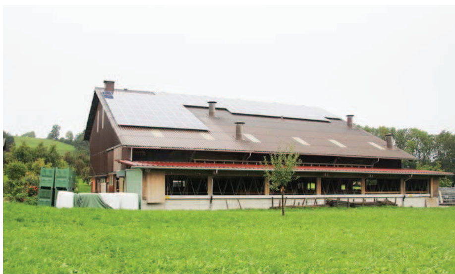
Le toit de la grange est « mis en location ». Les parents et les frères et sœurs d'Andrea y exploitent une installation photovoltaïque d'une puissance maximale de 30 kWp.
