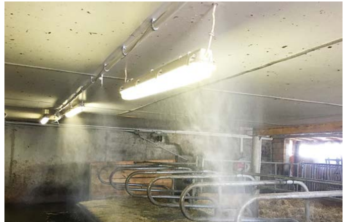
Vernebelung Stallgang entlang der Hochboxen.
